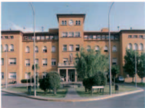
HOSPITAL DE VILADECANES REFORMA LABORATORI
